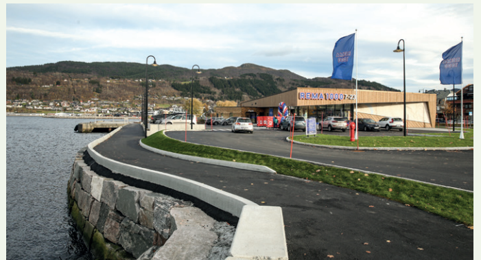
Utbygger har bygget kyststi mot sjøen som del av tomteavtalen med kommunen.
