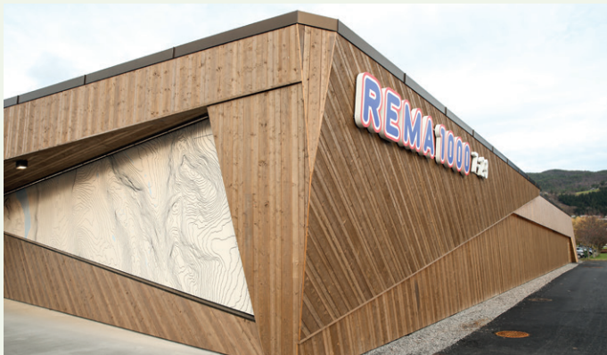
Ved inngangen er fasaden dekorert av Steni-plater med print av et kartutsnitt av Sykkylven.
