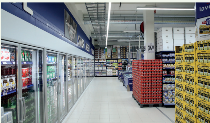
Fra innsiden av butikken. Vi ser gulvene er flislagt. I taket er det eksponerte hulldekker og betongsøyler, ventilasjon og leddbelysning.
