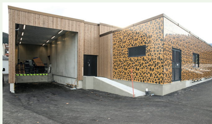
Bygget har rampe for vareleveranser på baksiden mot sjøen, med lager innenfor.
